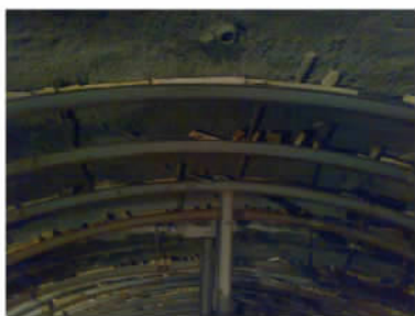
图2 型钢环向临时支撑
