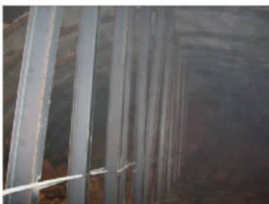
图3 型钢竖向临时支撑
