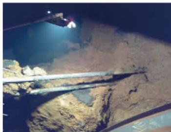
图5 坍塌段溶洞
