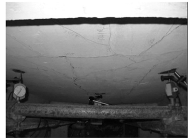
(e) 楼板底部
