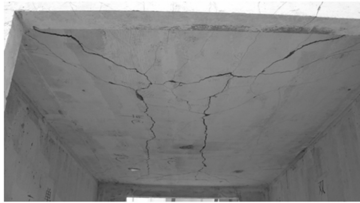
(a) 楼板底部
