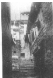
图3 寨内的过街楼
