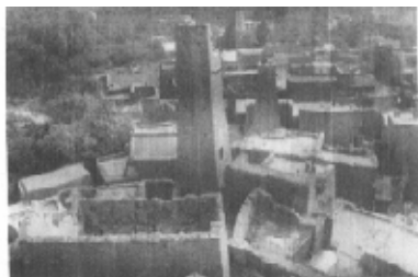
图4 寨内的空中道路
