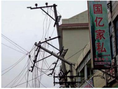
图9 塔杆折断致使电线破坏<sup>[43]</sup>
