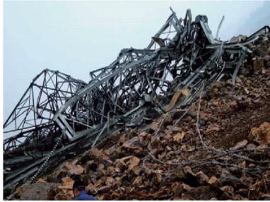
图10 汶川地震中高压输电塔因地质灾害倒塌<sup>[43]</sup>
