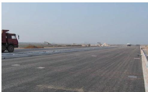
图8 石墨沥青混凝土试验路下部电极埋设施工图<sup>[54]</sup>
