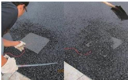
图9 石墨沥青混凝土试验路上部电极埋铺施工图<sup>[54]</sup>
