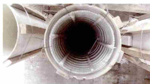
(c) 将GFRP筋放入PVC管中
