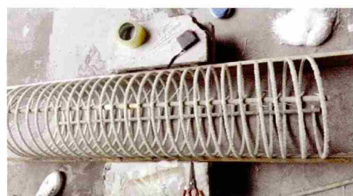
(a) GFRP筋的绑扎
