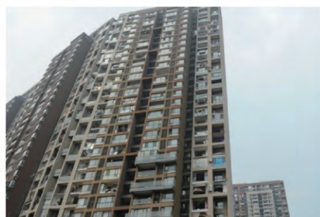
图 9 某万科高层破坏情况
