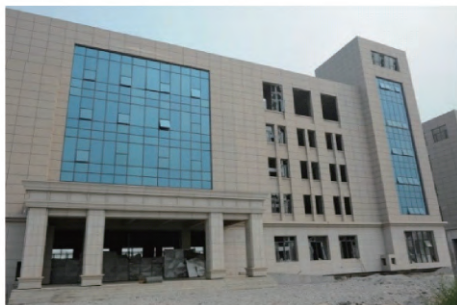
图11 汤浅公司未完工楼 Fig. 11 YUASA Co. Ltd. uncompleted building
