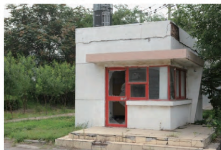
图 8 某单层砌体结构
